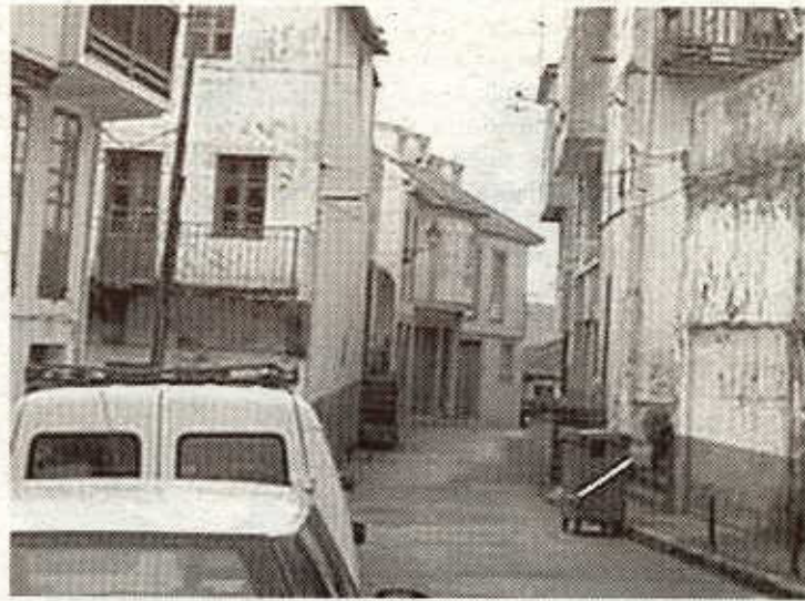
El Ayuntamiento mejorará el pavimento de la rúa Nova
